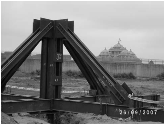
Fig. 7. Pile Load Test Setup
